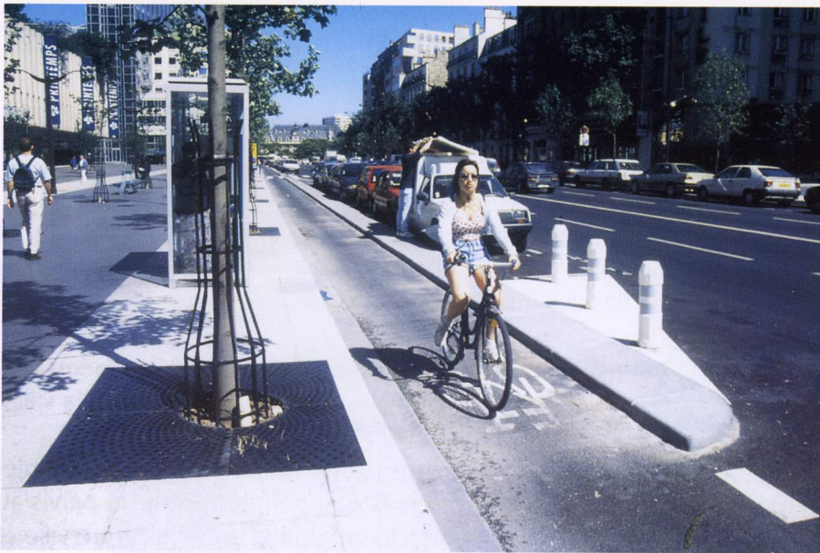
La piste cyclable unidirectionnelle est isolée du stationnement par un séparateur en béton. Le bord du trottoir côté chaussée est traité en granit avec une forme de quai pour intégrer une ligne de plantations et le mobilier urbain, ici une cabine téléphonique
