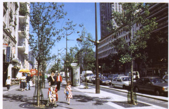
Le bord du trottoir côté chaussée est traité avec du granit en forme de quai pour intégrer une ligne de plantation et le mobilier urbain, ici une sanisette
