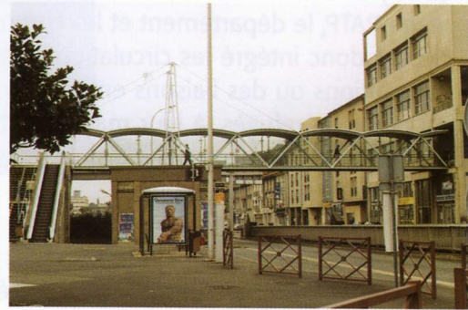
La passerelle Solférino traverse un immeuble
