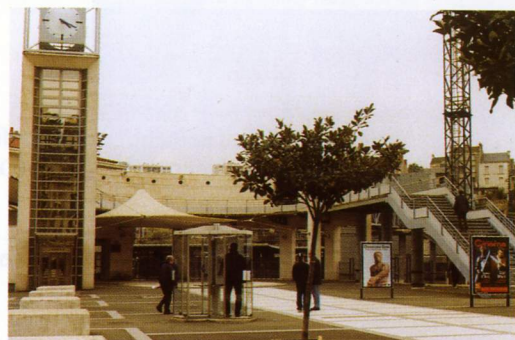
Ascenseur et petite passerelle d'accès aux quais, construits à l'occasion de l'arrivée du TGV
