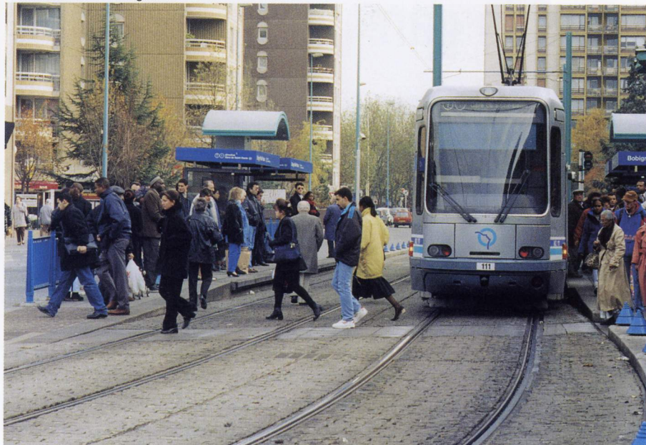
Bobigny: une station au cœur du quartier
