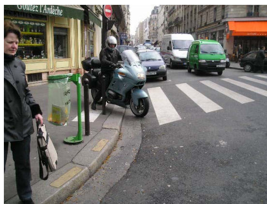
Photo 8 : Illustration du croquis 6 : passage piétons décalé, peu accessible aux PMR et dangereux pour les aveugles
