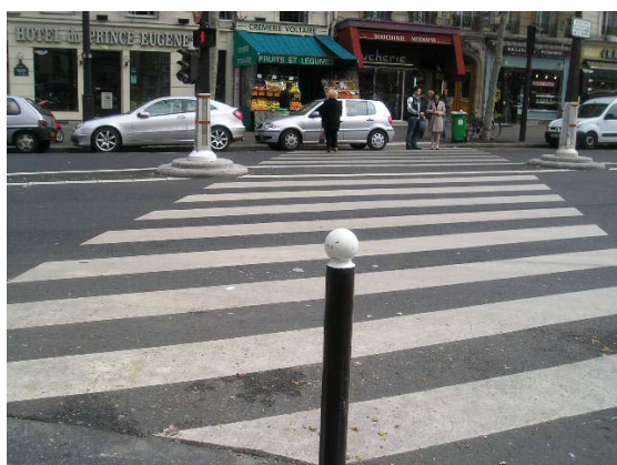
Photo 9 : L'absence d'avancée de trottoir favorise le stationnement illicite ; potelet au milieu gênant pour les PMR
