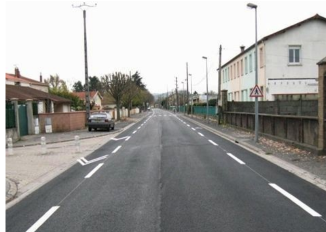
Chaussée à voie centrale banalisée en France
