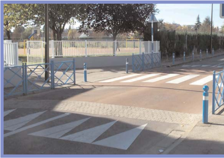
PHOTO 1 - : Plateau surélevé face à l'accès de l'école CONDORCET, en plus du plateau et de la signalisation, le mobilier urbain renforce la perception de la traversée aménagée.
