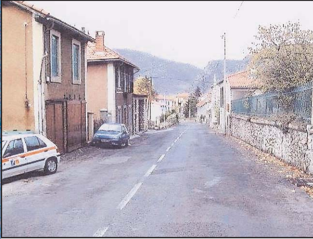
PHOTO 1 prise dans le sens sud-nord (pente)
