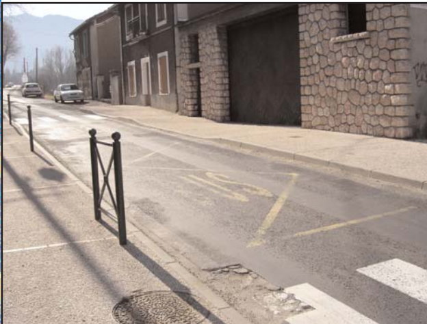
PHOTO 5 prise dans le sens nord-sud (rampe)
