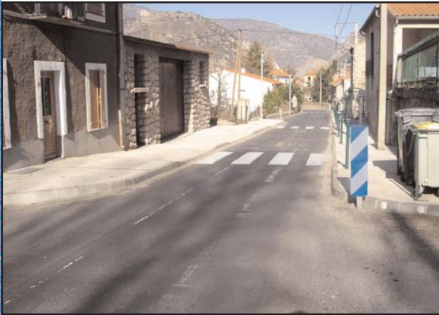
PHOTO 3 prise dans le sens sud-nord (pente)
