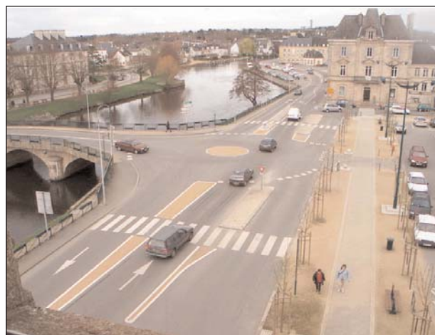
PHOTO 3 - Amélioration des échanges et de la sécurité côté Quai Niemen avec l'implantation d'un mini-giratoire.
