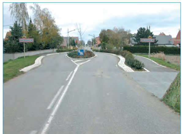
Chicane avec îlot central et voie d'évitement pour les cyclistes.
