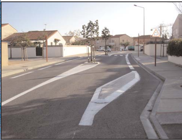
Dispositif de protection des cyclistes et de guidage au droit des chicanes
