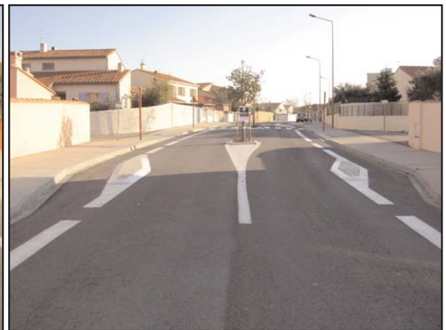
PROFIL EN TRAVERS 2 : chaussée à 2 voies de largeur 2,50 m avec plantations en axe (autorisant les manœuvres de tourne-à-gauche) et bandes cyclables
