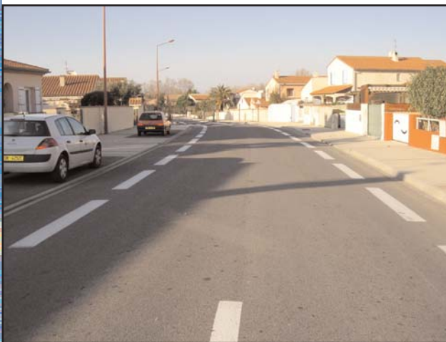
PROFIL EN TRAVERS 1 : chaussée bidirectionnelle de largeur réduite (4,60 m) avec bandes cyclables (1,20 m côté trottoir et 1,40 m côté stationnement)
