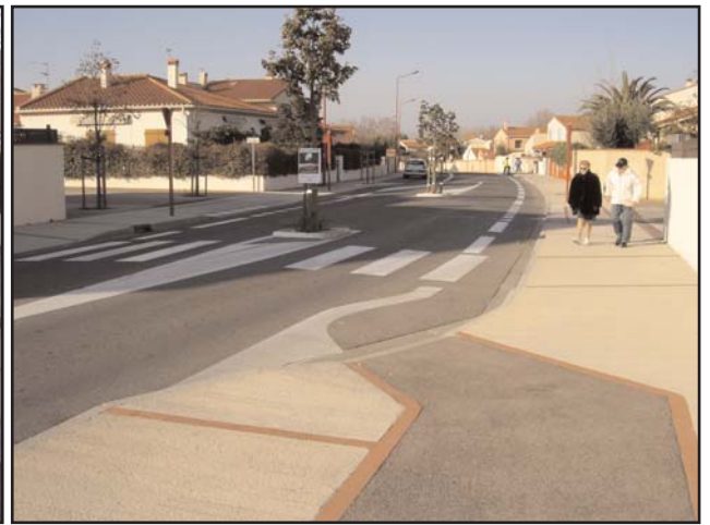
Raccordement entre la piste cyclable au niveau du trottoir et la bande cyclable
