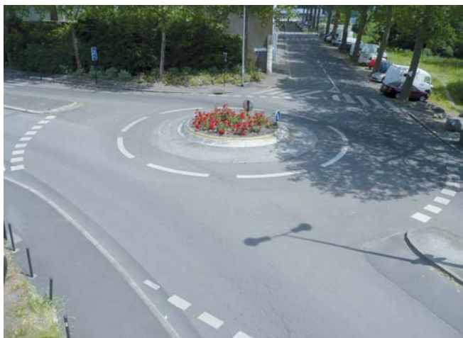
Source : CETE de l'Est
