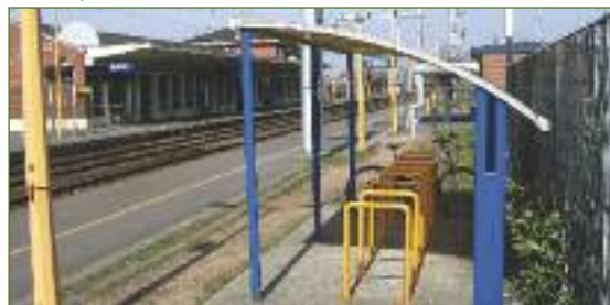
Stationnement couvert le long du quai.
