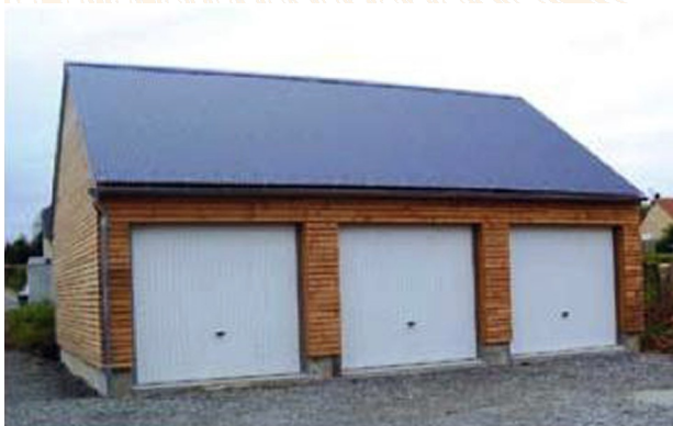
source : CETE Ouest
