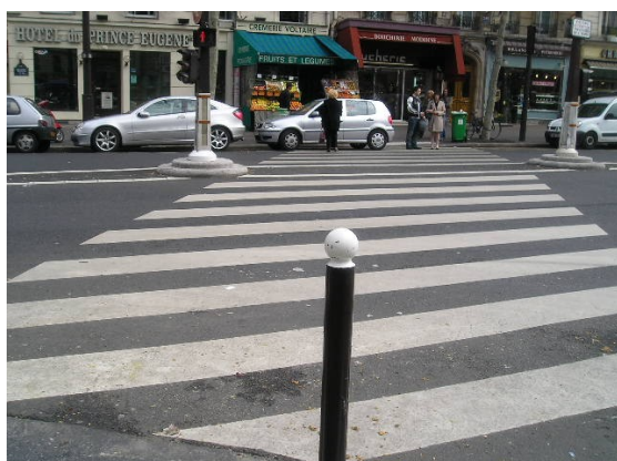
Photo 9 : L'absence d'avancée de trottoir favorise le stationnement illicite ; potelet au milieu gênant pour les PMR
