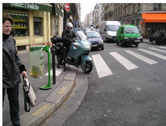
Photo 8 : Illustration du croquis 6 : passage piétons décalé, peu accessible aux PMR et dangereux pour les aveugles
