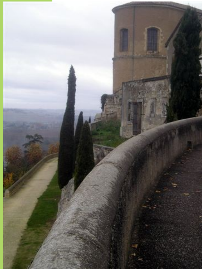
Dénivellations : cheminement de contournement à signaler
