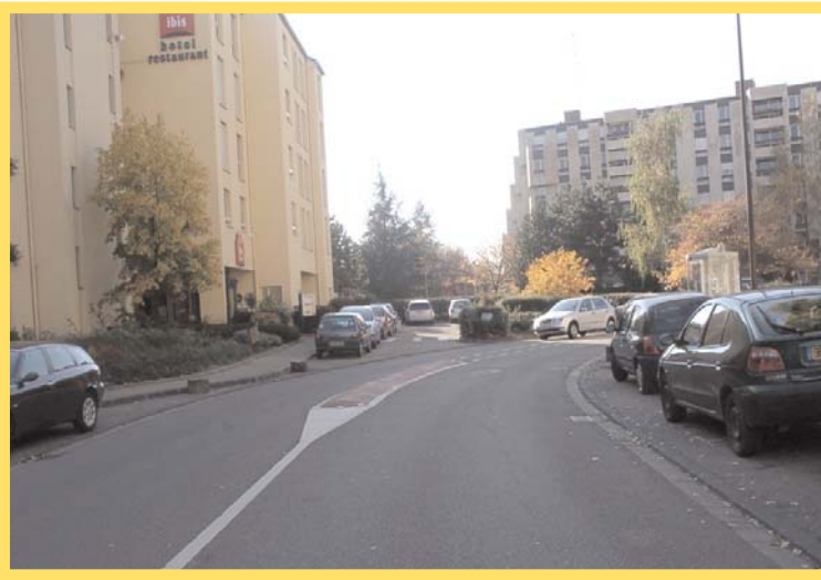
PHOTO 1 - Perception de la tête de l'îlot central bombé en entrée de courbe à droite avec une interruption pour l'accès à l'Hôtel. Stationnement latéral sur emplacements hors chaussée.
