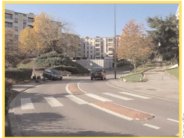
PHOTO 2 - Perception du tracé sinueux avec la séparation centrale. Bornes en béton sur le trottoir gauche pour empêcher le stationnement gênant. Possibilité de franchissement occasionnel des poids lourds et véhicules de secours. Mauvaise tenue des plots rétro réfléchissants en tête d'îlot.
