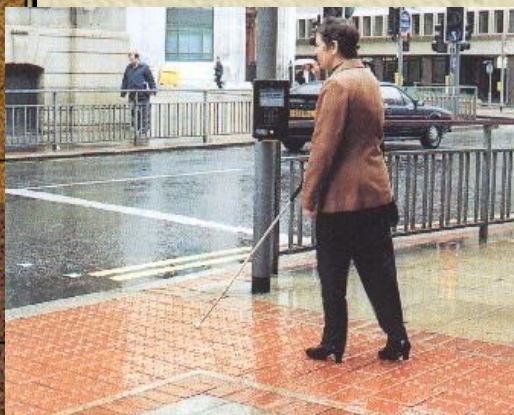
Photo du guidage au sol des aveugles au Royaume Uni (CEMT)
