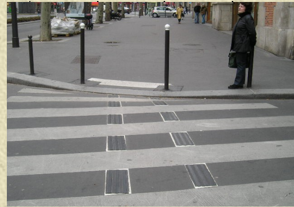
Photo 2 : Mise en place de : bandes guides pour à Paris, notamment lors de changement de direction
